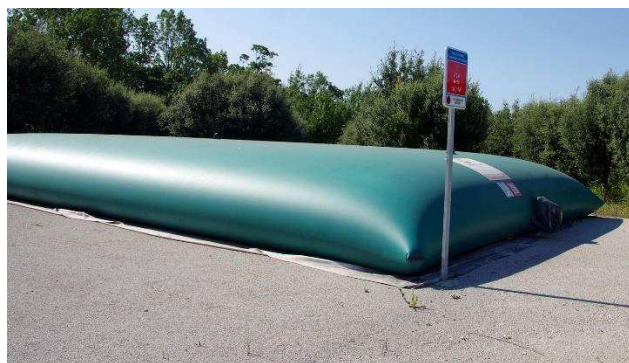
Photo 13 : bassine incendie et sol en remblai à l'entrée du site (24/08/2021)
