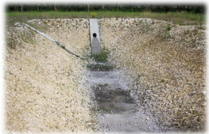
Photo 1 : bassin de décantation récent (24/06/2021)
